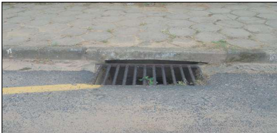
Figura 112 – Estrutura de microdrenagem (bocas de lobo) de Jaguariúna, com acúmulo de detritos nas guias e sarjetas.
