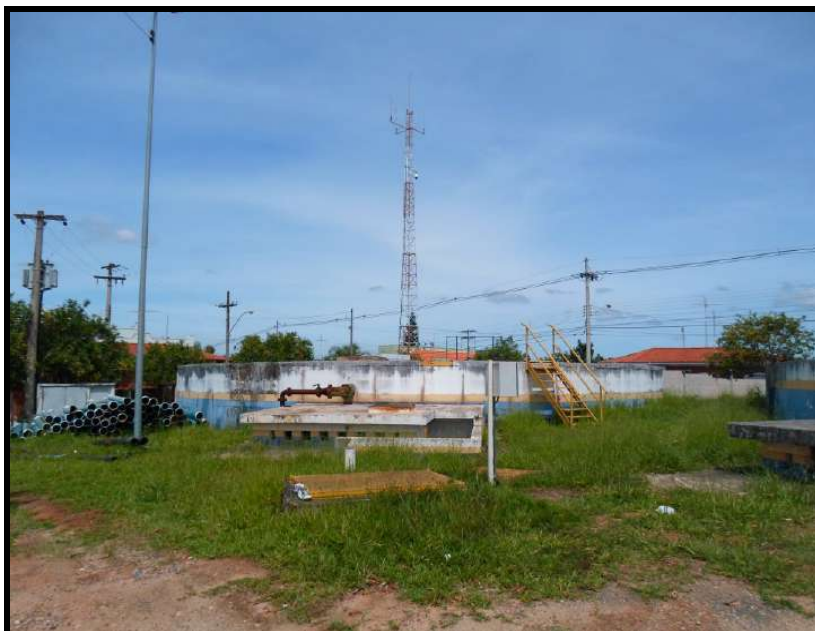
Figura 30 - Reservatório Semi-enterrado R4 - ETA Central.
