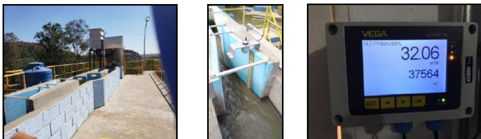
Figura 83 – Foto da Caixa de Areia, à esquerda e do Medidor de Vazão, à direita da ETE Vila Primavera.
