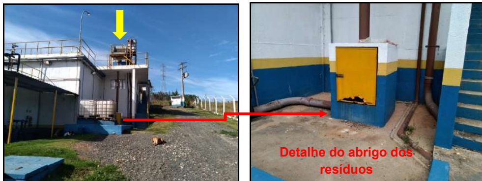
Figura 82 – Foto do gradeamento da ETE Vila Primavera.
