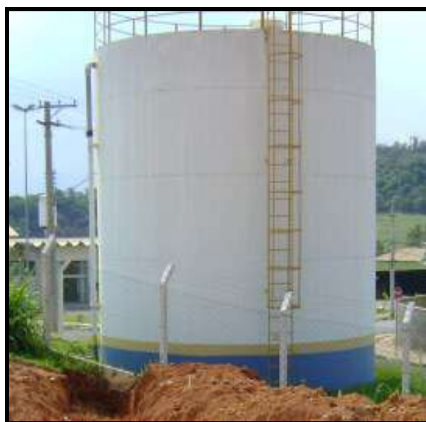
Figura 44 - Reservatório Elevado Pinheiros (200 m 3 ).
