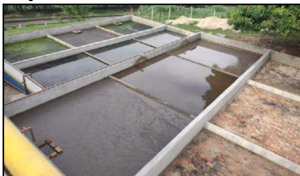
Figura 86 – Foto dos leitos de secagem da ETE Vila Primavera.
