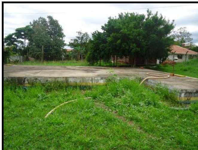
Figura 49 - Reservatório Enterrado ETA Ana Helena (200 m³).
