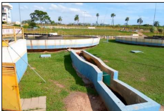
Figura 78 - Detalhe da Calha Parshall na Saída dos decantadores.
