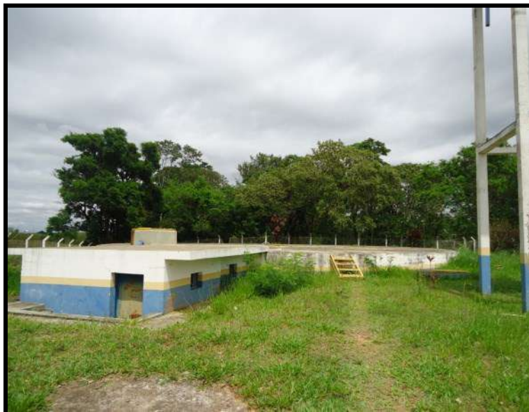
Figura 36 - Reservatório Nova Jaguariúna (600 m³).
