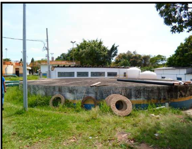
Figura 28 - Reservatório Semi-enterrado R2 - ETA Central.
