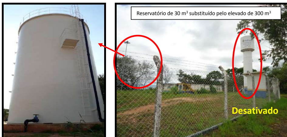
Figura 34 - Reservatórios Elevado Florianópolis II (300 m³) que substituiu o Reservatório Elevado Florianópolis (30 m³) - Terras do Capela
