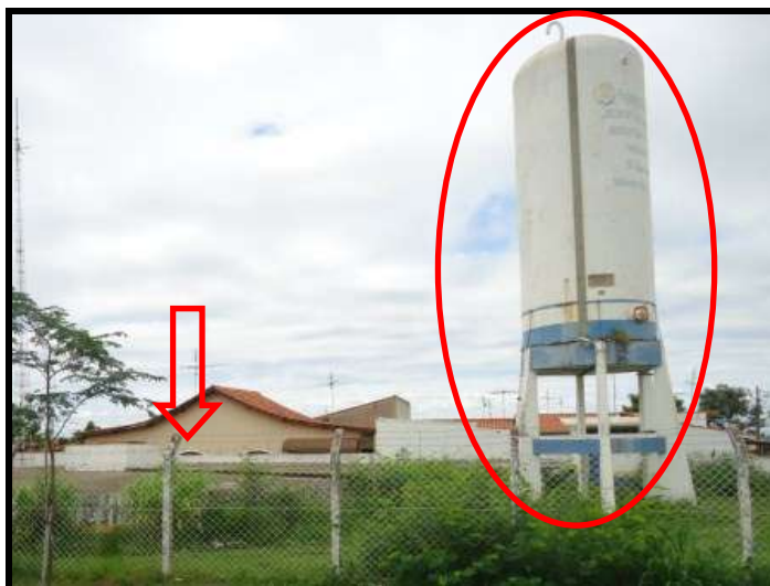
Figura 41 – Reservatório Enterrado Nassif I (1.200 m³); Reservatório Elevado Nassif II– 100m³ (Nassif e Chácaras Primavera).
