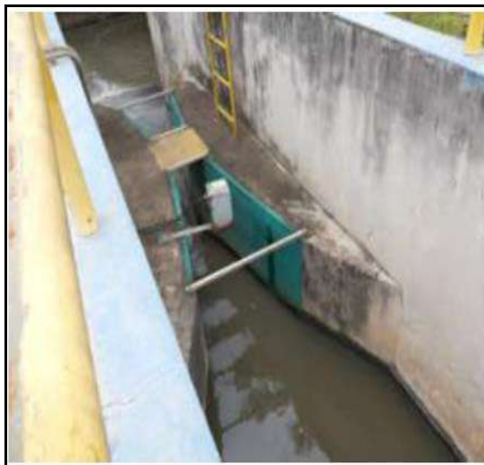
Figura 74 - Entrada do efluente com medidor Parshall e dispositivo ultrassônico.
