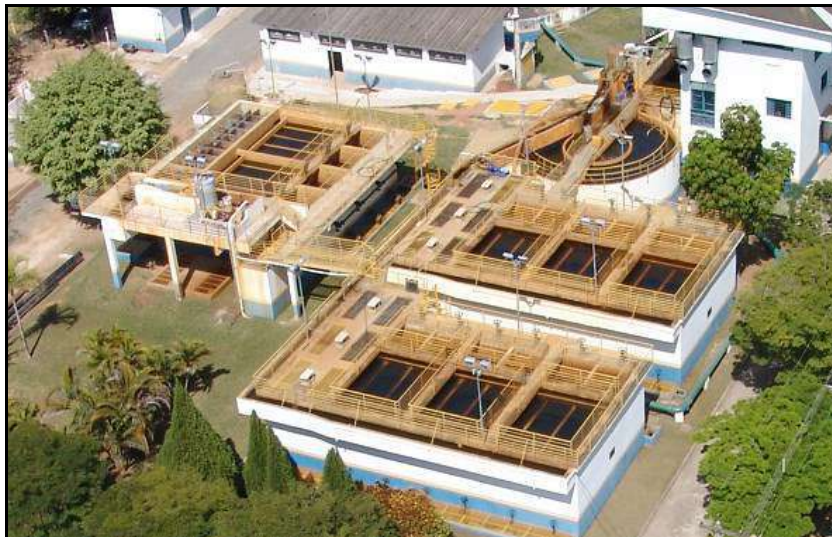
Figura 23 - Módulos de tratamento da ETA Central.
