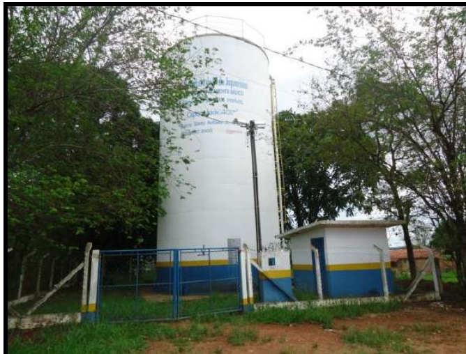
Figura 51 - Reservatório Santo Antônio do Jardim (400 m³).
