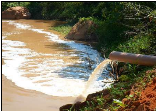
Figura 80 – Lançamento do Esgoto tratado na ETE – Rio Camanducaia.
