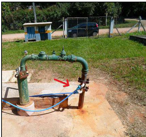
Figura 26 - Dosagem de produtos químicos do Sistema Poço Santo Antônio.
