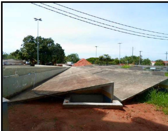
Figura 27 - Reservatório Semi-enterrado R1 - ETA Central.
